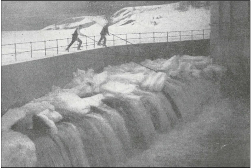
Abb. 6: Eiswächter beim »Picken«, wie das Entfernen von Eisanhäufungen an Wasserkraftanlagen in den Quellen bezeichnet wurde.
