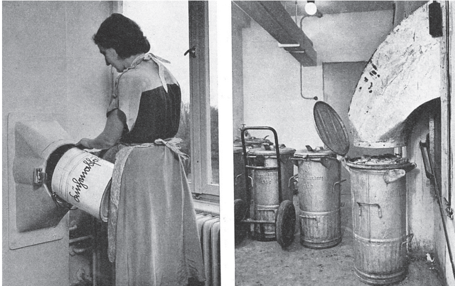
7 – Müllabwurfschacht in Hamburg (1955)
